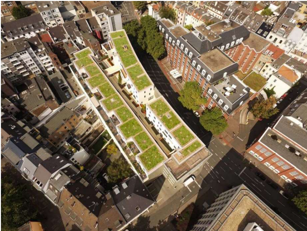
Abbildung 25: Luftbild des abgeschlossenen Projekts https://www.bauphasen.de/
