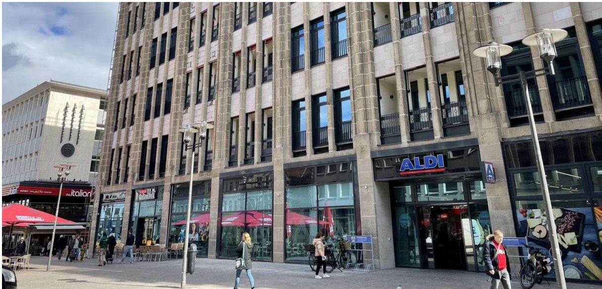
Abbildung 21: Fassade der umgenutzten Immobilie https://www.welt.de/wirtschaft/plus247262732/Vorbild-Recklinghausen-Die-Stadt-nach-Karstadt.html
